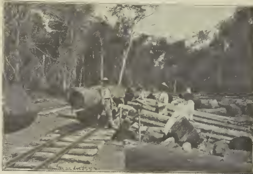
Ferrocarril americano para la conducción de maderos de caoba. Varias compañías americanas establecidas en México para la explotación de la caoba han introducido en el país este medio rápido de transporte
